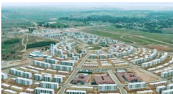
Imagem 12 - Projeto para Angola previa a construção de 40 mil moradias
